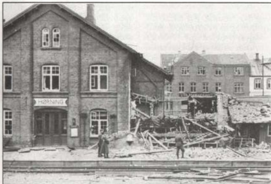
Sprængning af signalhus ved Hørning Station den 22. april 1945.
