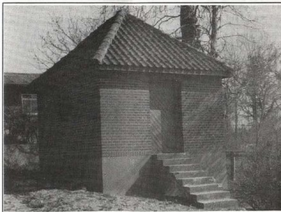
Vandværket i Hårby
