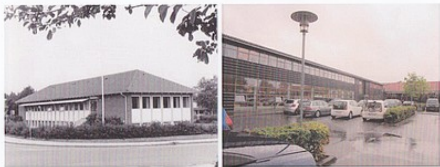
Hørning kommunekontor 1965 og 2013. Bygningerne rummer i dag borgerservice og bibliotek, og hjemmeplejen har forskellige kontorer. Siden 2008 er Hørning en del af Skanderborg kommune med administrationskontorer på Adelgade i Skanderborg.
