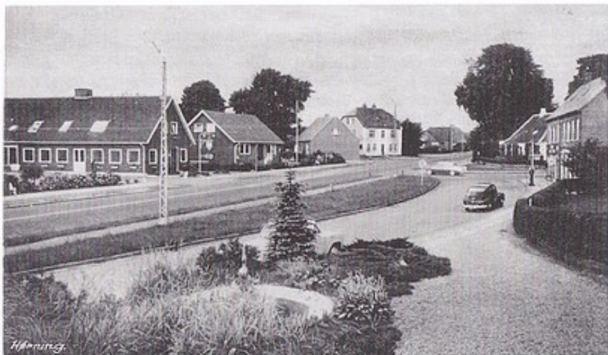
Hørning bymidte 1963, kommunekontoret er den hvide bygning i midten af billedet, Skanderborgvej 1, kaldet Alfahus og bygget i 1909 af mejeribestyrer Smedegaard. Bygningen var Hørning kommunes første administrationsbygning (se årsskriftet for 2006). Landkommunerne Veng og Mesing-Adslev har aldrig haft kommunekontorer. Forvaltningen skete fra sognerådsformandens private stuer. Sognerådsformand Roldskov, Nr. Vissing inddrog folkestuen til kontor og murede en dør til køkkenet til, så folk kunne tale uforstyrret med ham. Veng indgik i Hørning kommune i 1970 og Adslev-Mesing i 1962.
