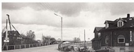
Barometeret ses til venstre. Billedet er fra 1972, hvor byggeriet af den nye jernbanebro er i gang.
