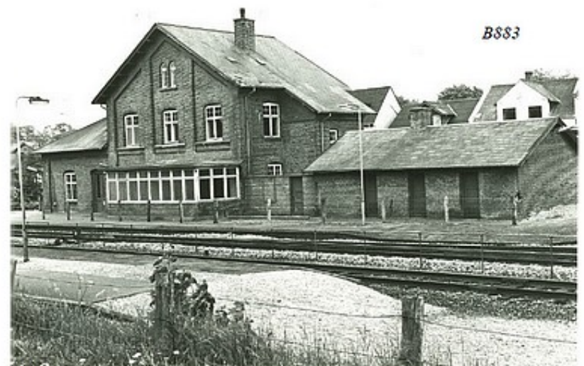
1982. Høring Stations tomme bygninger efter at betjeningen stoppede den 15. september 1975. Togene stoppede dog stadig indtil 26. maj 1978. Bygningen blev nedrevet 16. november 1983. Glasverandaen ved vi ikke så meget om, men vores gæt er, at det er et nyt signalhus, som er bygget efter sabotage den 6. marts 1945.
